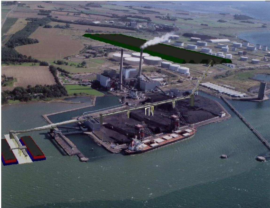
Figur 20: Visualisering af det samlede projekt. Pier 2 ses til venstre. Pieren er forbundet med kullageret i højre side af figuren ved hjælp af et højebånd. På den del af højebåndet, som ses midt i billedet over det eksisterende kullager, ses tværbåndet, som skal fordele kul i det eksisterende kullager. Der opføres en silo på det eksisterende kullager, der ikke er medtaget på denne visualisering.
