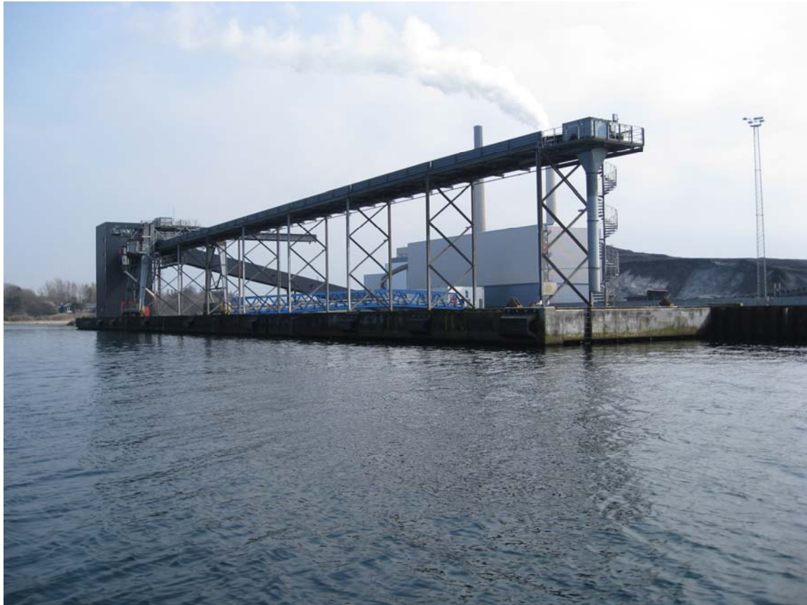
Figur 17: Den eksisterende pier med lasteanlæg. Kul læsses i pramme fra det langsgående transportbånd ved hjælp af et tværgående transportbånd og en tragt, som ses ved omkasterstationen (bygningen bagerst i billedet, hvor kul omkastes (overføres) fra ét transportbånd til et andet).
