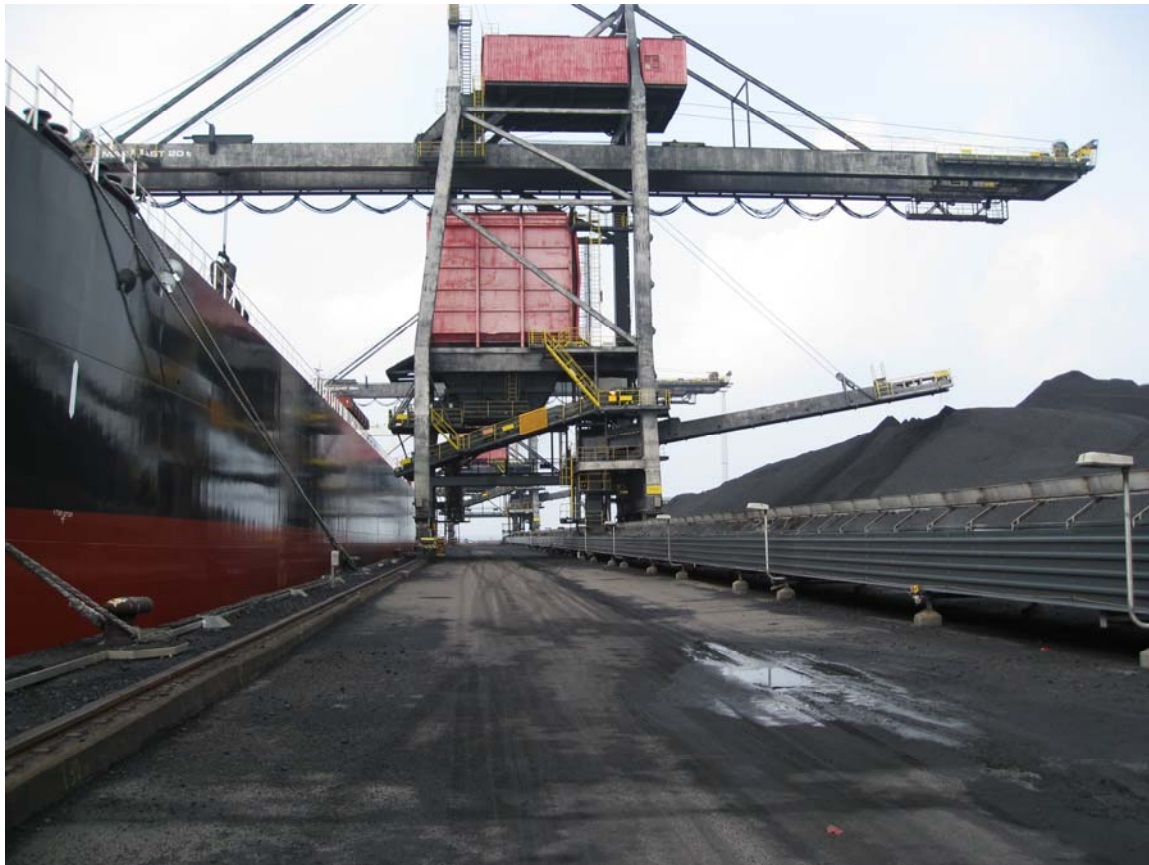
Figur 10: De eksisterende lossekraner med en rød tragt. Under tragten anes en spildbakke, som vil blive større i de nye kranser. Til højre i billedet ses det eksisterende transportbånd som fornys.
